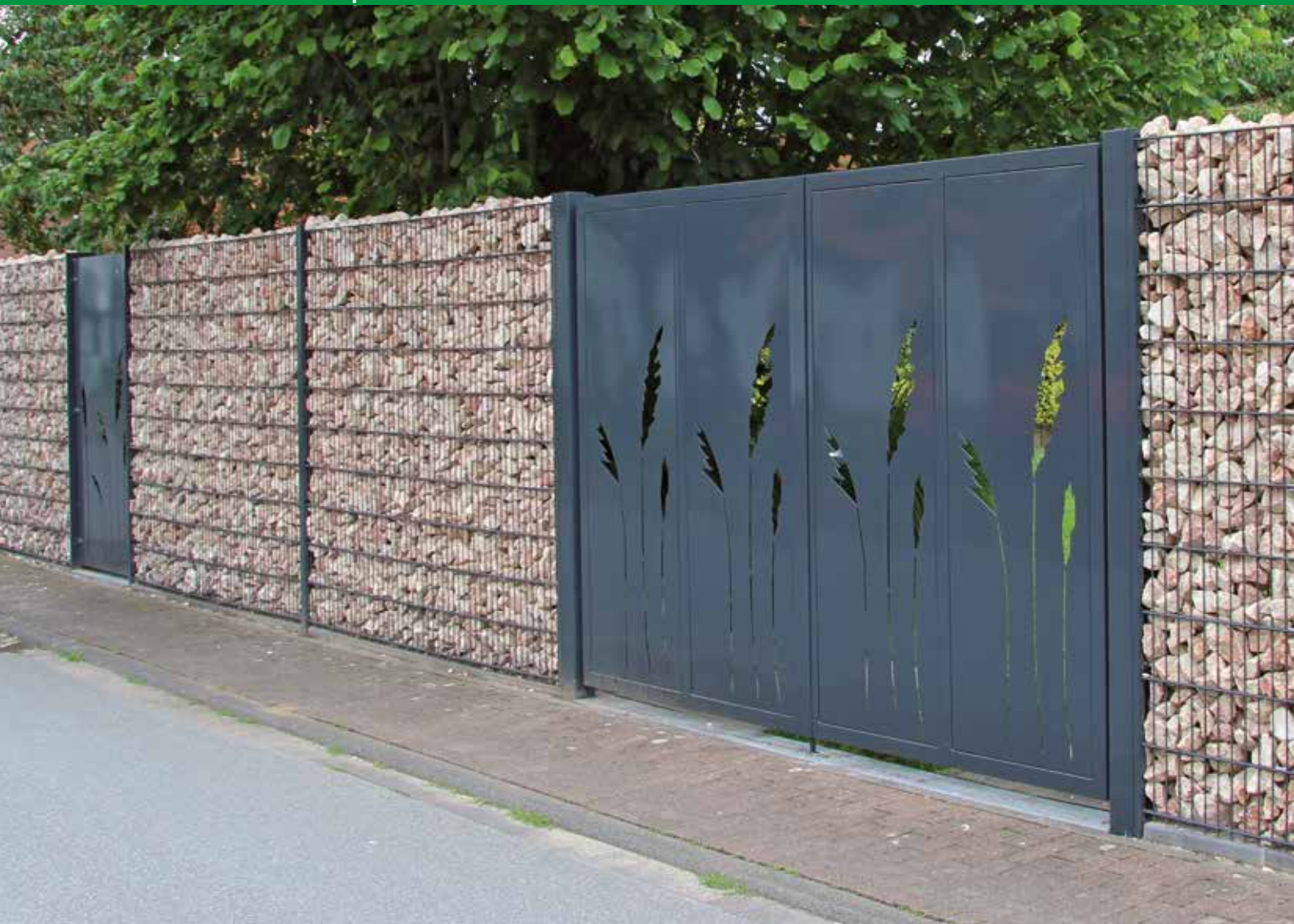
Gabionen in Kombination mit Designblech-Elementen Modell Schilf, anthrazit pulverbeschichtet
