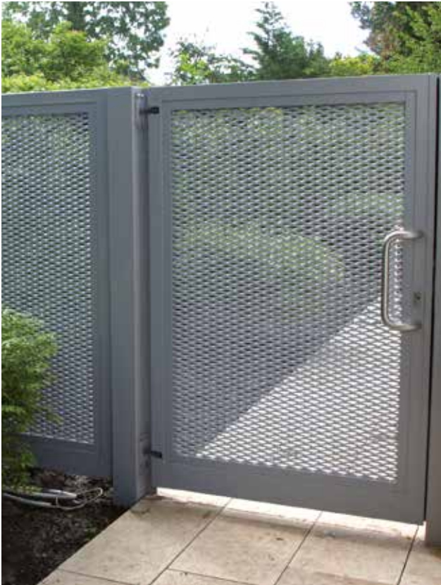
Tor mit Streckgitterfüllung
