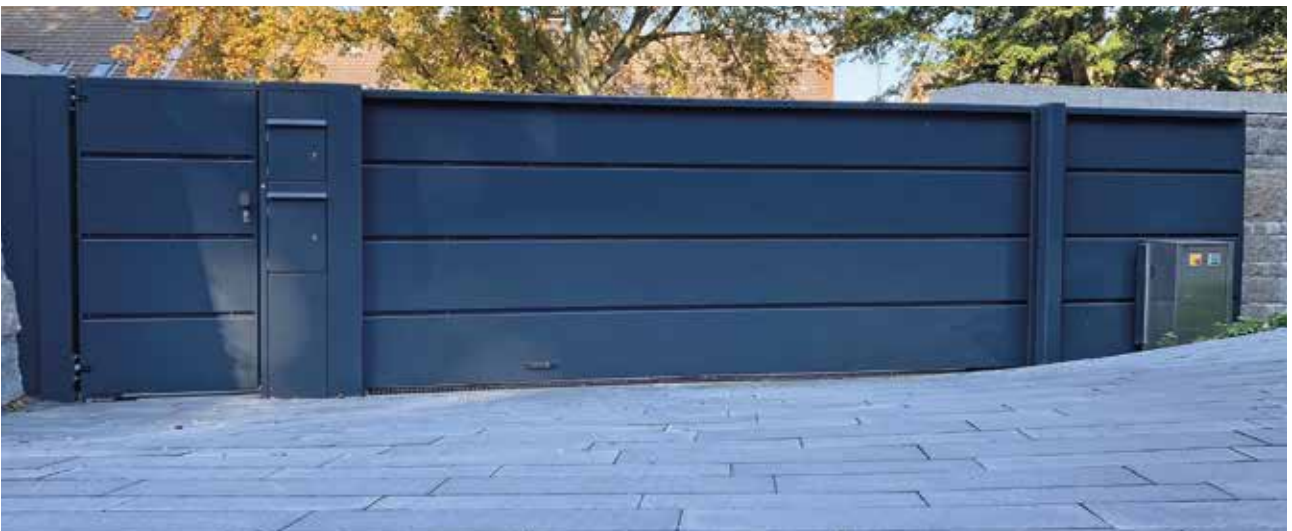
Schiebetor mit Kassettenblechfüllung und waagerechter beidseitiger Sicke
