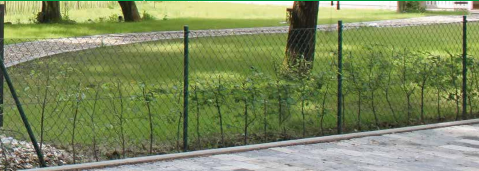
Maschendrahtzaun mit Rohrpfählen, grün beschichtet
