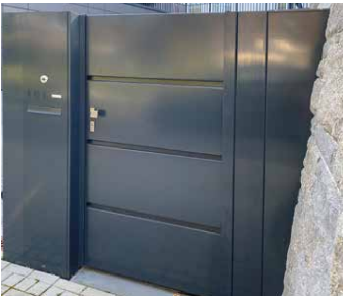
Tor mit Kassettenblechfüllung und waagerechter Sicke
