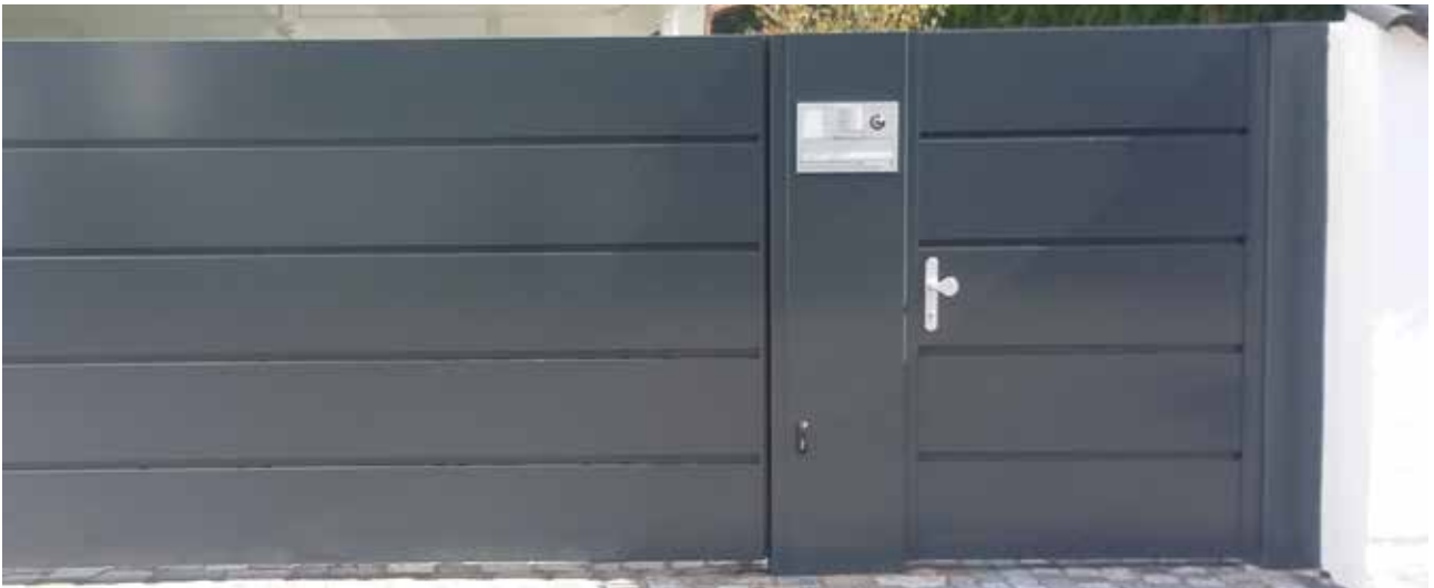
Toranlage mit Kassettenblechfüllung und waagerechter Sicke
