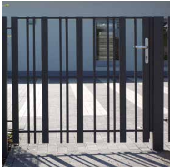
Tor mit aufgesetzter Stabfüllung
