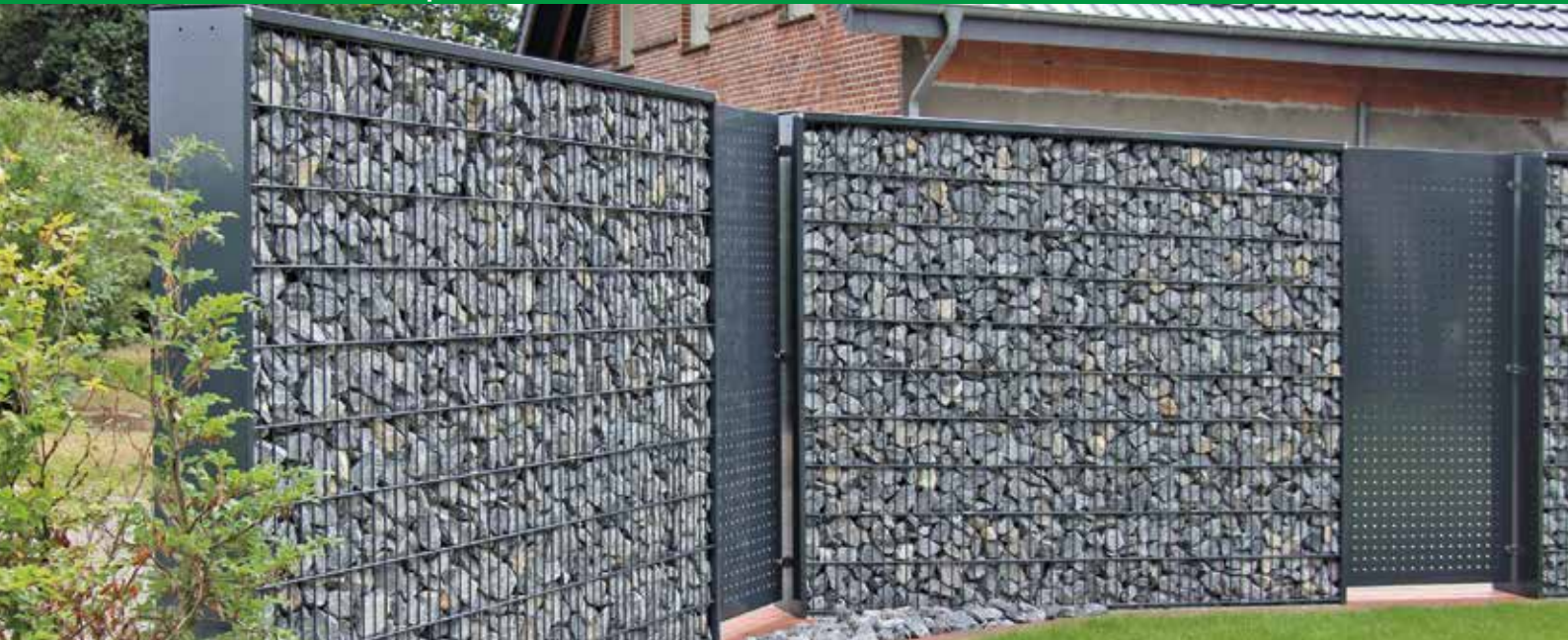
Gabionen in Kombination mit Lochblech-Elementen, anthrazit pulverbeschichtet
